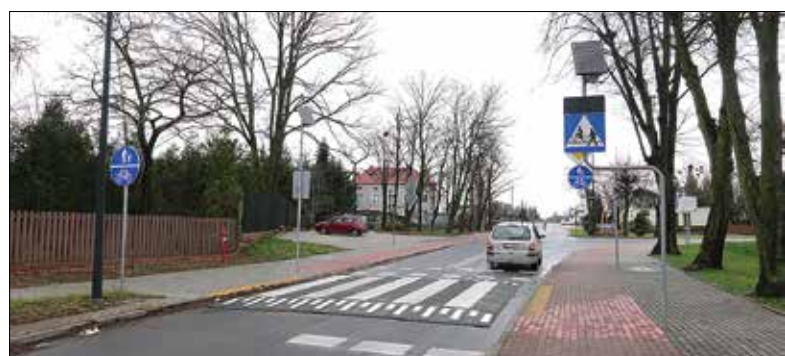
Na ul. Targowej w tym roku powstało nowe przejście dla pieszych
