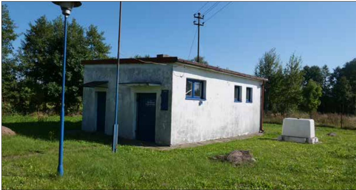
Stacja uzdatniania wody w Górze Bałdrzychowskiej zostanie zmodernizowana
