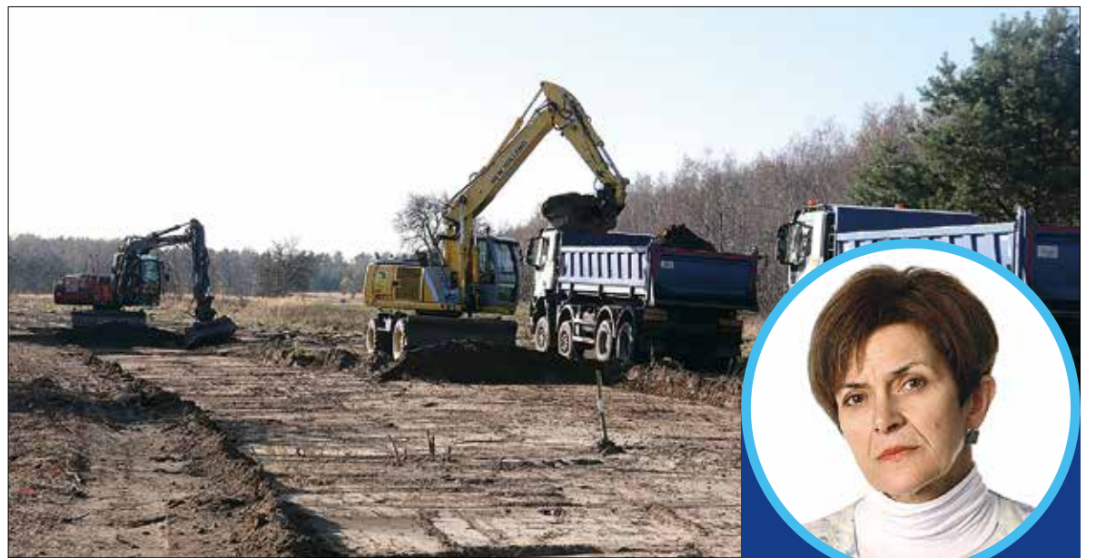
Maszyny na budowie drogi w Pradze
