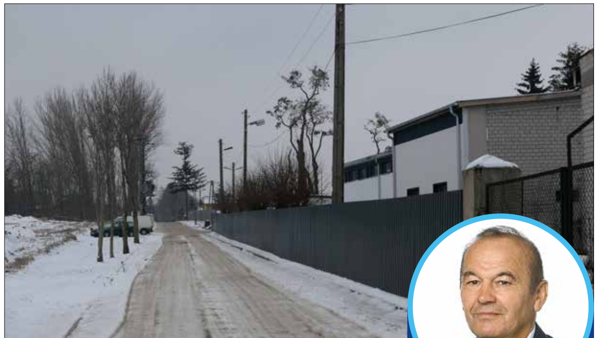
Droga do przebudowy
