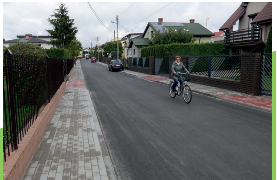
Ul. Deczyńskiego po remoncie
