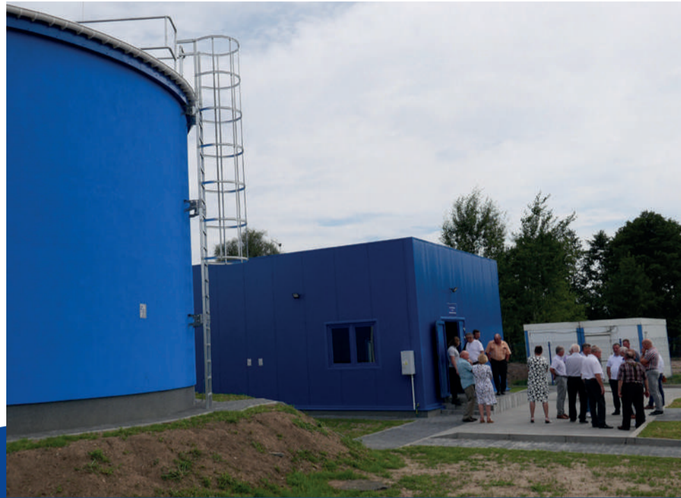
Zmodernizowana stacja uzdatniania wody w Górze Bałdrzychowskiej działa na pełnych obrotach
