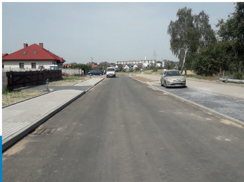
Trwają prace na trzech ulicach w południowej części miasta
