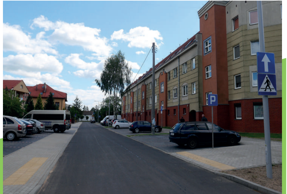
Zmodernizowana ul. Przyszłość
